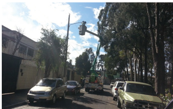
Imagen 7. Fotografías de la Instalación de equipo para medición de alumbrado público.
