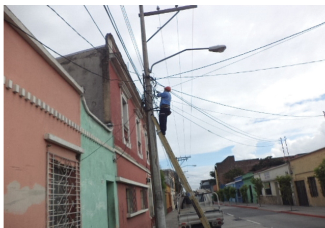
Supervisión Retiro Equipo
