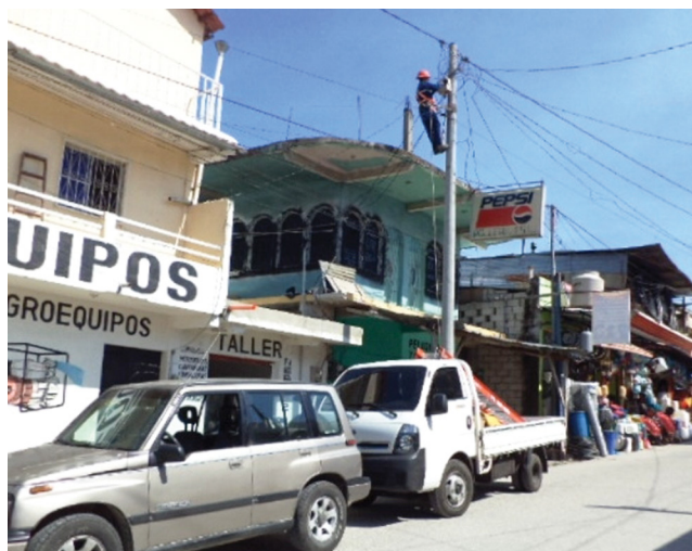
Supervisión Retiro Equipo
