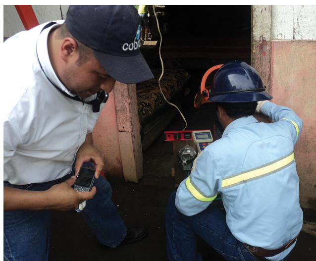
Verificación de Medidores
