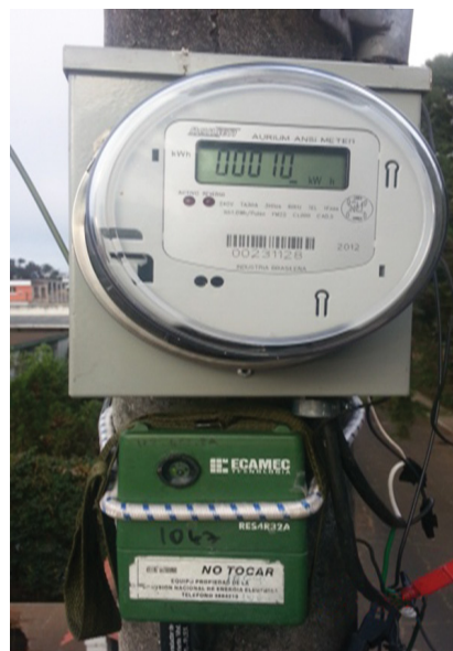
Imagen 8. Fotografía del equipo para medición de consumo de energía de alumbrado público.
